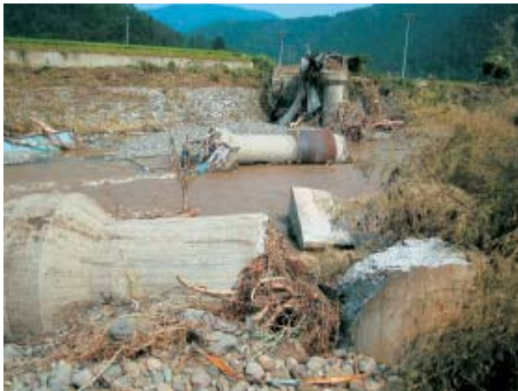
写真1 JR第5足羽川橋梁の被害状況（手前の橋脚が折れている）
