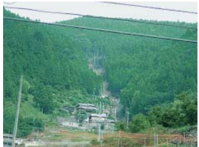
写真3 上那賀町白石地区で発生した斜面崩壊。今回の災害では、最も民家が集中している場所で発生した。
