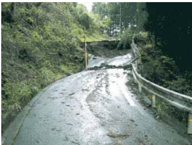
写真2 大規模な崩壊が発生した木沢村阿津江地区。崩壊地の上部には多数の亀裂が見つかっており、それら亀裂を結んだ線上に位置する林道に2m近い段差が現れた。崩壊地上部に残った不安定土塊は、少しずつ移動しているものと思われる。
