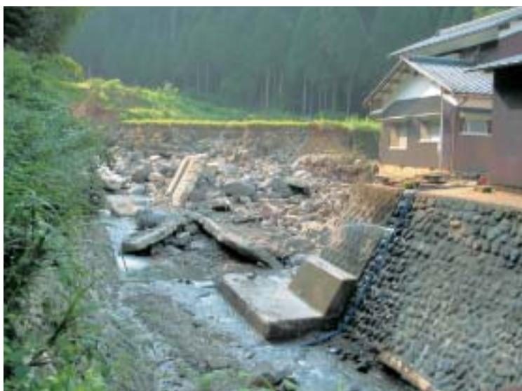
写真3 蔵作地区の側岸侵食状況（蔵作川沿い集落の上流端付近）
