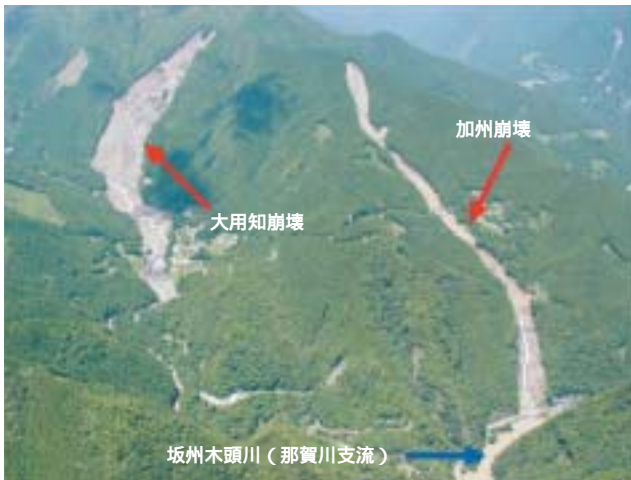
写真1 木沢村の大用知地区・加州地区で発生した斜面崩壊の様子。両崩壊によって流出した土砂は、那賀川の支流である坂州木頭川に流れ込んだ。加州崩壊の後方(写真右上)には、小畠地区の崩壊も見える。
