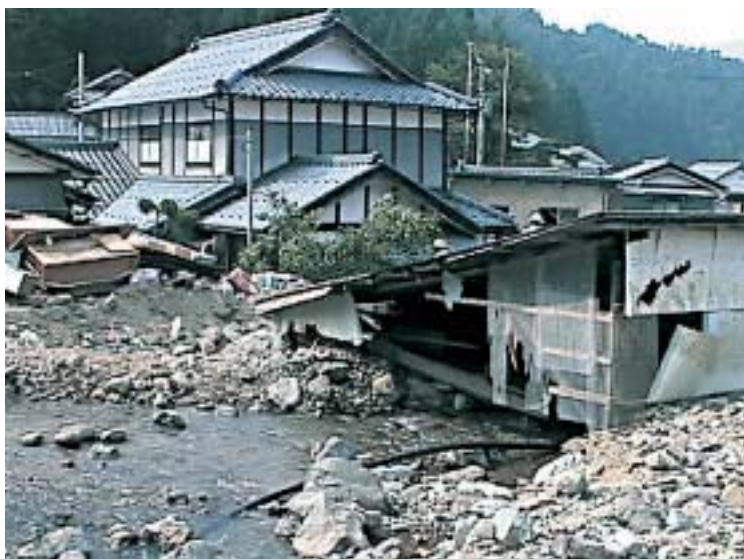
写真2 蔵作地区の土砂氾濫状況（土砂で埋まり、川が流路を変えて流れている）
