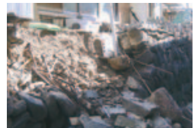
写真4 擁壁の崩壊(玄界島)
