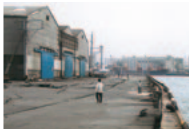
写真6 液状化に伴う岸壁の損傷 (福岡市沖浜町)
