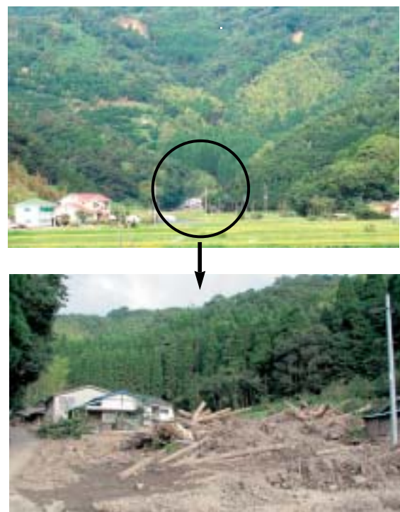
図3 新御堂被災地の遠景と被災状況 崩壊は上の写真の左上部に見える
