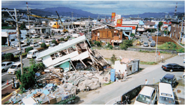
写真2 竜巻の中心が通過した浜町付近の建物被害
