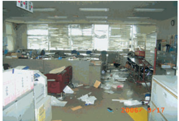
写真4 窓ガラスが割れた室内の様子（延岡市消防本部提供）
