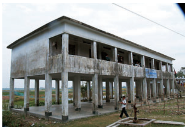
第5図 サイクロンシェルター、高潮・高波を避けるために高床式になっていて、2階が避難場所
