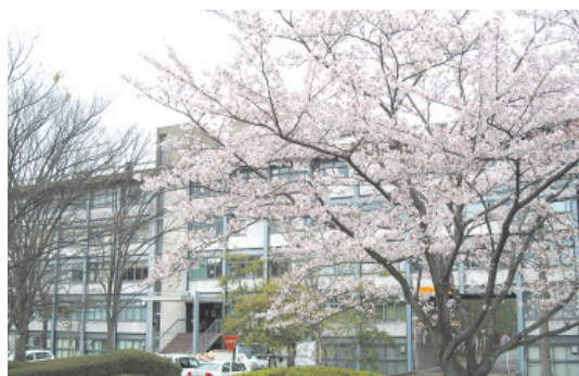
耐震改修前の本館正面
