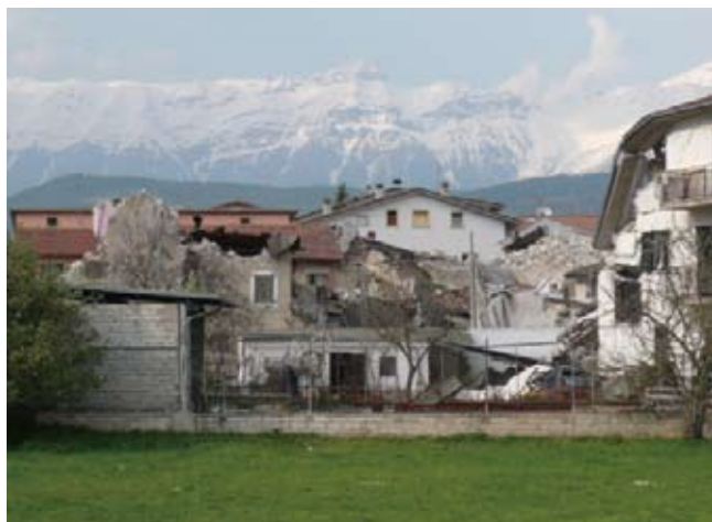
写真2 オンナでの建物の被害
