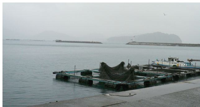
写真2 魚類養殖筏区画が全滅した礫浦漁港。写真奥右側の防波堤開口部外にあった区画が被災した
