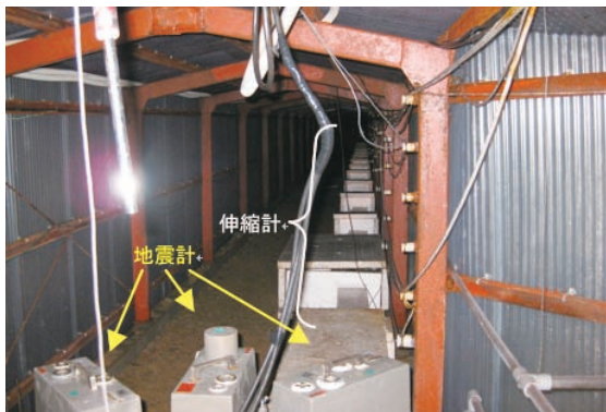
図2 蔵柱観測坑道内部
