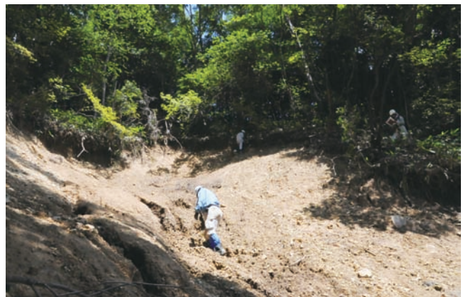
写真4 写真3の上流にある土石流発生源頭部のひとつ。
