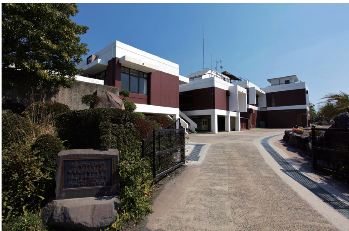
耐震改修後の火山活動研究センター桜島火山観測所
