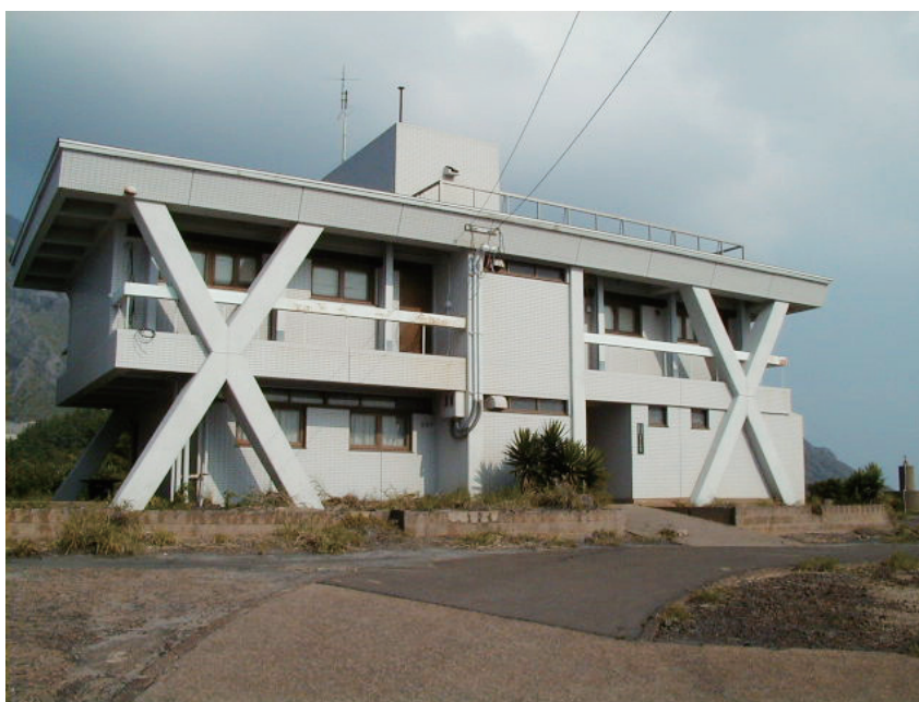
耐震改修工事中の移転先となったハルタ山観測室（旧本館）
