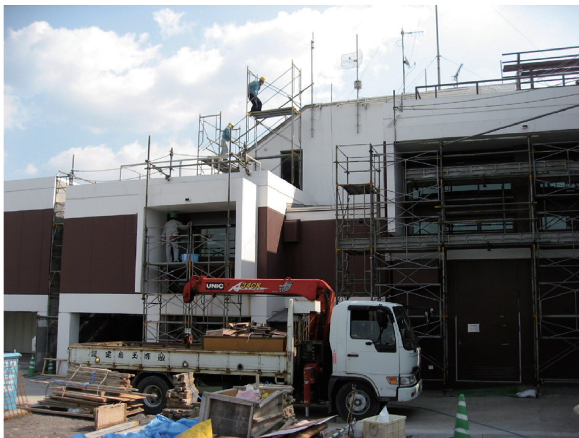
耐震改修工事中
