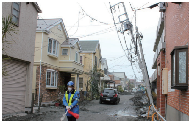
写真4 噴砂で覆われた道路と傾いた電信柱
