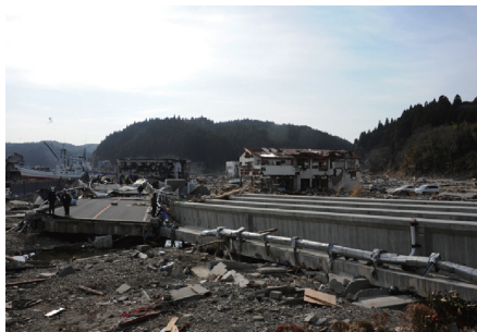
南三陸町歌津地区のコンクリート橋の流出 (P9)
