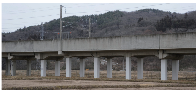
写真1 鋼板巻立て補強された新幹線高架橋
