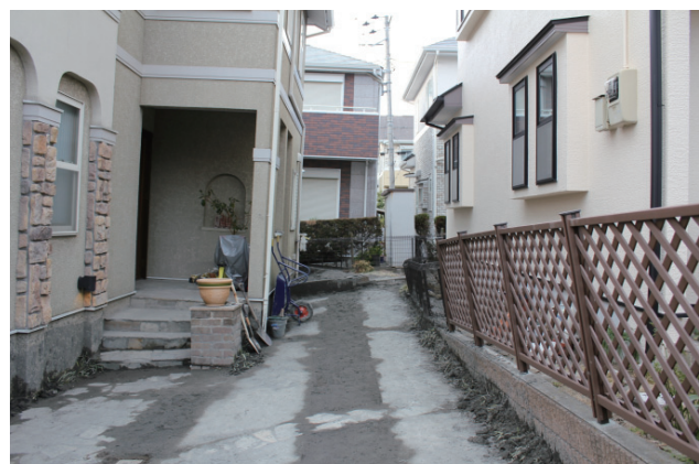
写真5 傾斜した住宅
