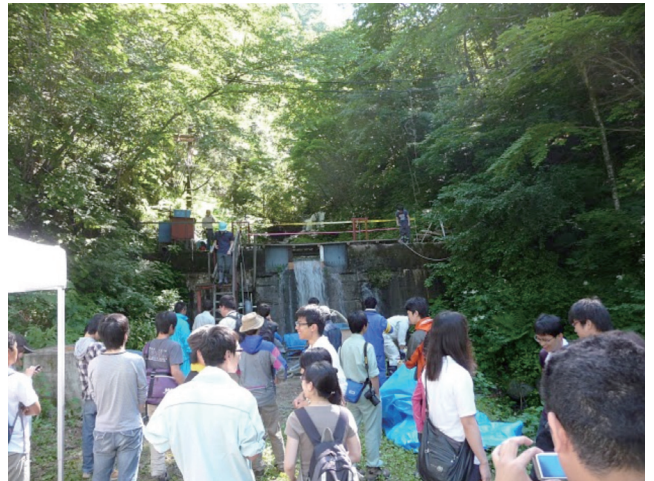
土砂吸引工法による土砂排砂実験
