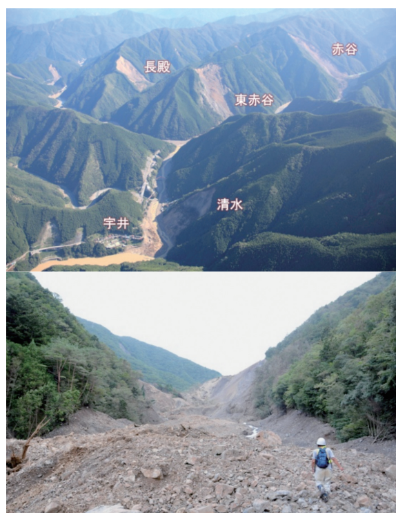
写真4 奈良県五條市大塔町において発生した大規模斜面崩壊 (道窪幸雄 2011.9.10 撮影) (上) と赤谷天然ダム堤体の下流側 (下)
