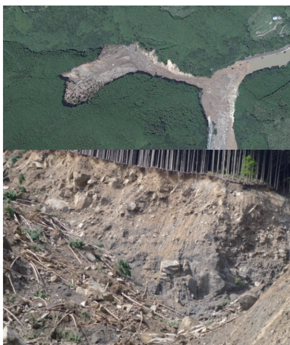
写真2 和歌山県田辺市中辺路町栗栖川地区地すべりの空中写真 (国土地理院) (上) と崩壊源頭部 (下)
