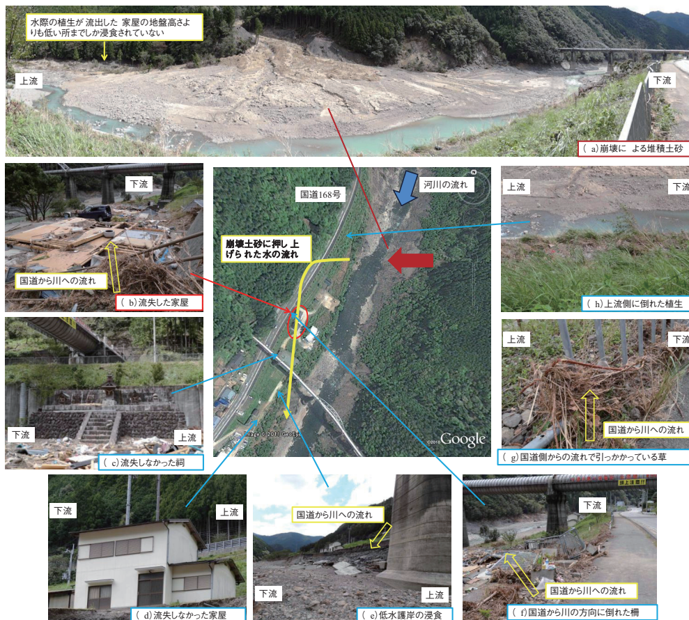
写真1 十津川村野尻における被災状況
