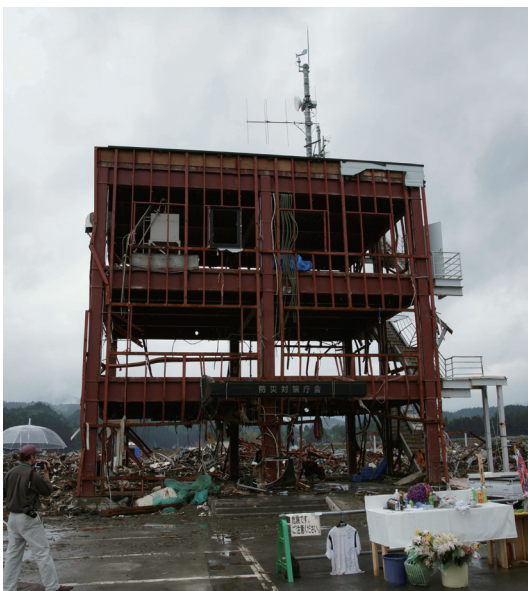
写真1 南三陸町の災害対策棟
