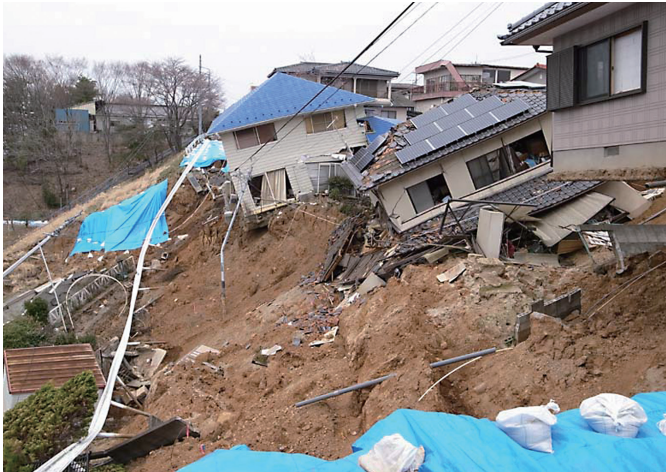
谷埋め盛土地すべり末端部の崩壊（福島市あさひ台）（P2）
