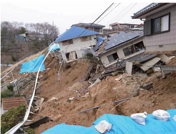
写真1 谷埋め盛土地すべり末端部の崩壊（福島市あさひ台）
