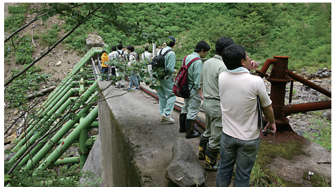
写真2 白水谷の砂防ダム現地研修
