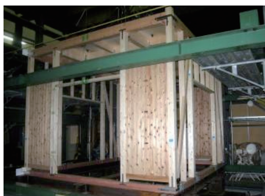
写真1 「壁柱工法」の実証実験
