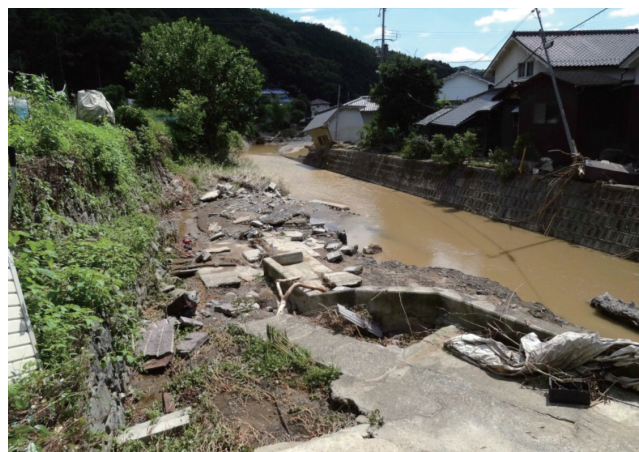
写真2 前川橋下流の家屋流失箇所 (8月16日)
