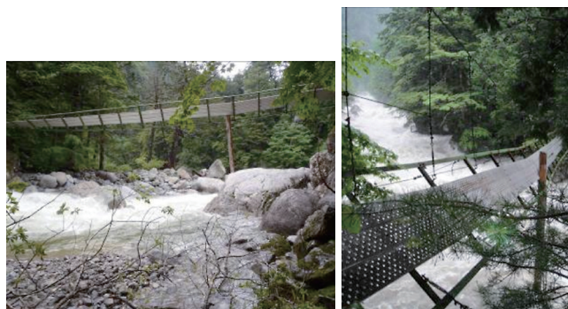
写真1 (左) 通常時の河川 (右) 降雨開始から約30分後の様子。降雨開始後まもなく河道には逃げ場がなくなっています。
