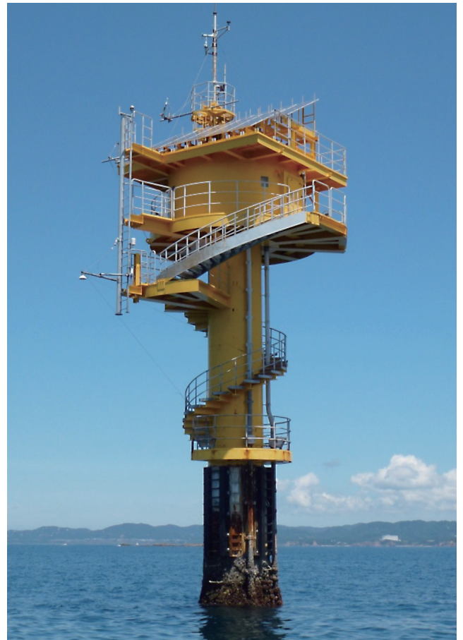
写真1 田辺中島高潮観測塔
