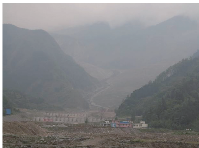
写真7 银杏溝の崩壊下部。流路工や床固め工が進められている。（2013年5月15日撮影）
