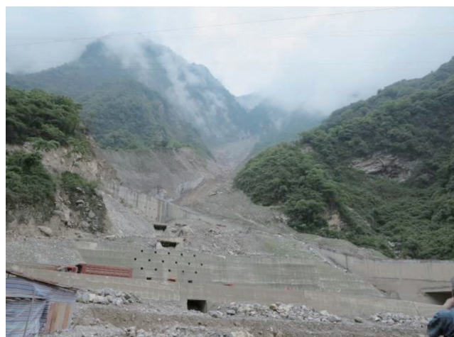
写真5 清平の渓流対策。地震時に谷に堆積した土砂が下方の道路を繰り返し閉鎖してきた。初期の導流堤と砂防堰堤は破壊された。
