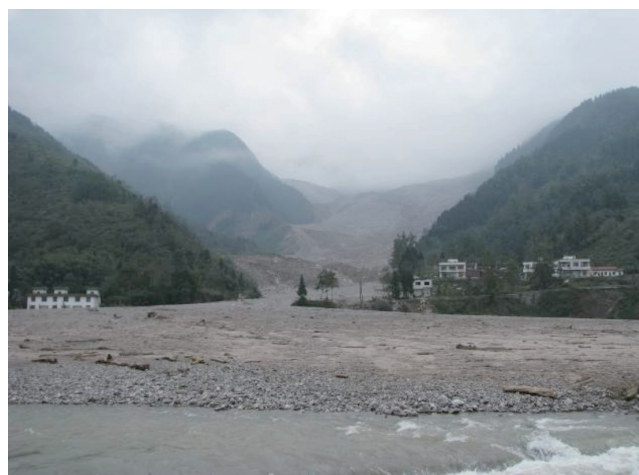
写真6 清平の银杏溝の崩壊下部（汶川地震による2番目に大きな崩壊、2009年5月5日撮影）。地震直後には、土石は支流の谷の出口で止まっていたが、その後、降雨時に土石流となって流出し、本流を一旦閉塞した。
