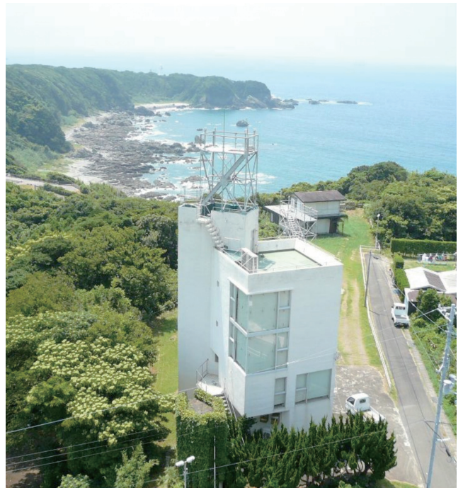
写真 1 潮岬風力実験所研究室本館
