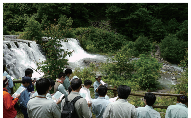
写真3 しのぶ砂防堰堤
