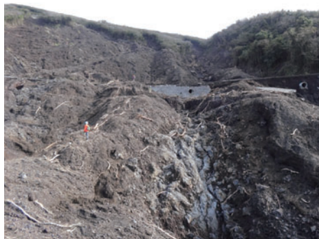
2013年 台風26号で発生した伊豆大島の表層崩壊
