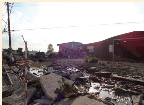
図3 鬼怒川堤防決壊地点周辺の被害状況(2)(9月12日撮影)
