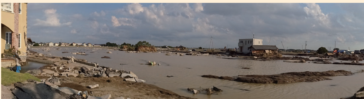
図2 鬼怒川堤防決壊地点周辺の被害状況(1)(9月12日撮影)
