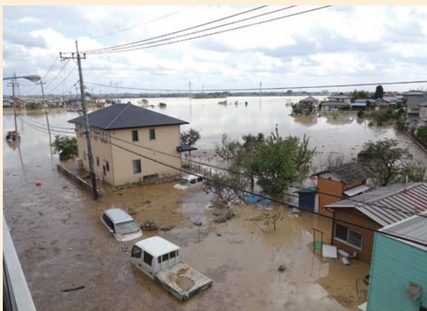
図1 国道354号線の高架橋からみた常総市の浸水状況(9月12日撮影)
