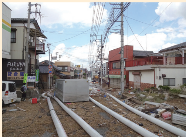
図5 常総市水海道の浸水状況(9月12日撮影)
