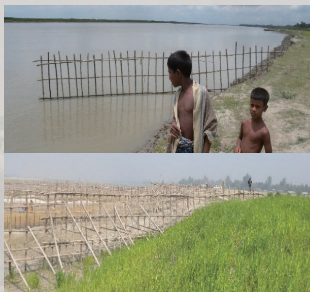
図5 上の写真：洪水前にバンドルを設置(下部の透過部分(竹製)のみ完成。上部の不透過のフェンス部分は未設置)。 下の写真：洪水発生1年後に形成された河岸付近の土砂堆積部分が麦畑に変身。再生された土地が自分の土地であることを作付けてアピール。
