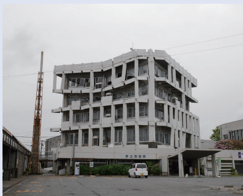
図2 半壊した宇土市役所庁舎(地震防災研究部門 山田真澄 撮影)
