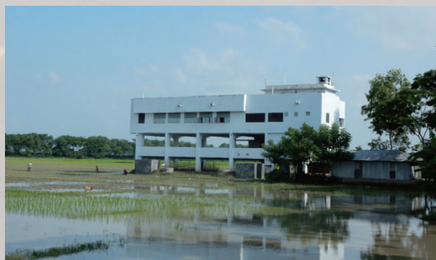
図8 サイクロンシェルター。3階に人、2階に家畜が避難 (Sarankhola Upazila, Bagerhat District)。
