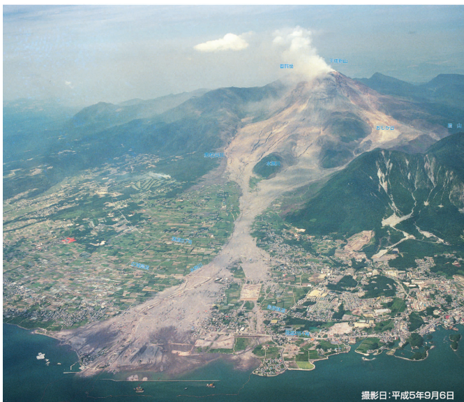
図4-1 雲仙・普賢岳による火砕流と土石流に覆われた被災地(1993年)
