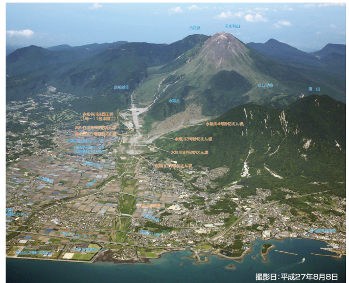
図4-2 砂防ダム、導流堤や新たな宅地が完成した2015年の水無川 (国土交通省雲仙復興事務所提供)
