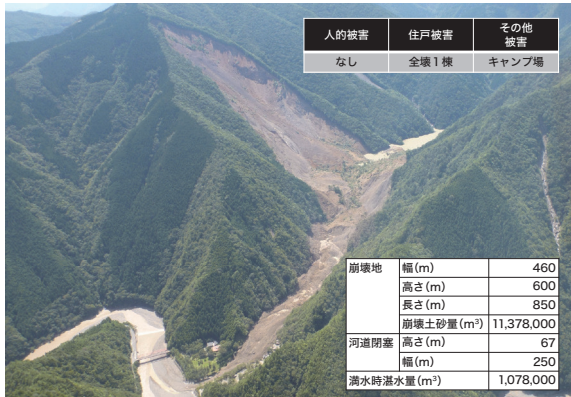
川原樋川赤谷(五條市大塔町清水)に形成された天然ダム(国土交通省近畿地方整備局紀伊山系砂防事務所提供のものを一部改変)
