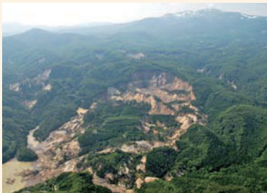
ほぼ水平なすべり面に沿って移動した大規模地すべり (2008年岩手・宮城内陸地震) Large-scale landslide moved along almost horizontal slip surface (2008 Iwate-Miyagi Nairiku earthquake)
