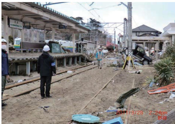
自然災害研究協議会による2011年東北地方太平洋沖地震津波調査 Field survey on tsunami damage by the 2011 off the Pacific Coast of Tohoku Earthquake
