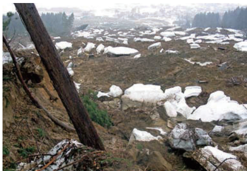
融雪によって発生した地すべり（新潟県上越市国川地区） Thaw water-induced landslide caused serious damages to a local community. (Kokugawa, Joetsu, Niigata)
