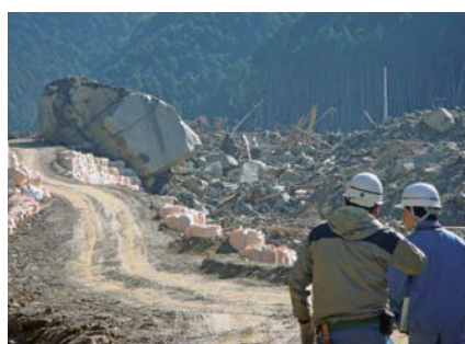
深層崩壊による土石流 Debris flow due to a deep landslide
