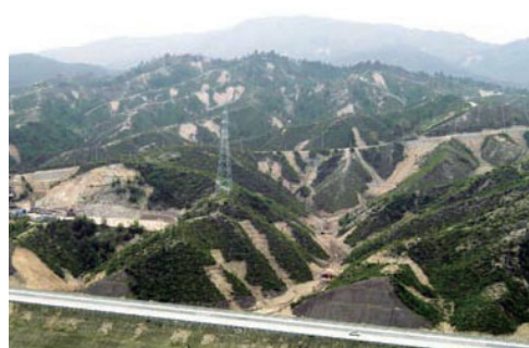
豪雨による風化花崗岩の表層崩壊（2003年台風ルーサ、韓国） Shallow landslides induced by rainstorm, Typhoon Rusa, Korea, in 2003
