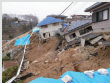
2011年東北地方太平洋沖地震 によって発生した地すべりと住 宅の被害 Collapse of housing lot by landslide induced by the 2011 Tohoku Earthquake
