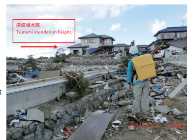
宮城県七ヶ浜町での津波痕跡 と調査の様子 Tsunami trace and survey in Shichi-ga-hama coast in Miyagi Prefecture
