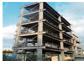
A-3鋼構造実大試験架構
