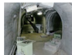
宮崎観測所の観測坑内における地殻変動観測 Crustal deformation measurement in the observation tunnel of Miyazaki Observatory
