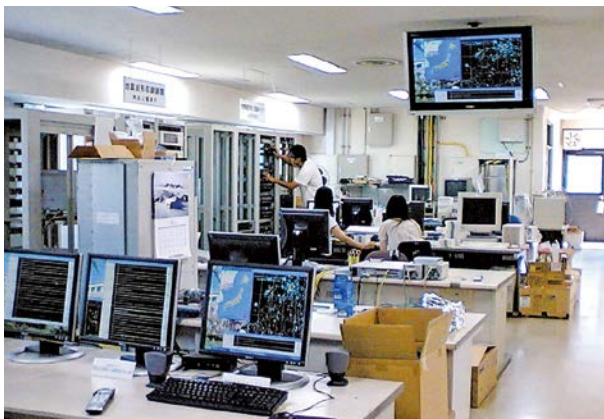
テレメーター装置室。ここに、日本各地の地震観測記録や地殻変動連続観測記録がオンライン・オフラインで集まる。 The telemeter room: Online and offline data from observation networks for earthquakes and crustal deformation are processed.
