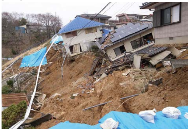
2011年東北地方太平洋沖地震によって発生した地すべりと住宅の被害
