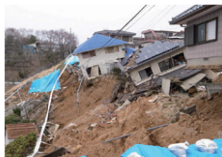
2011年東北地方太平洋沖地震によって発生した 地すべりと住宅の被害 Collapse of housing lot by landslide induced by the 2011 Tohoku Earthquake
