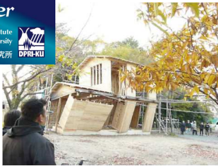
補強試験体の倒壊直前の状況 (4P)
