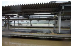
浸水したJR亀岡駅 (6P)
