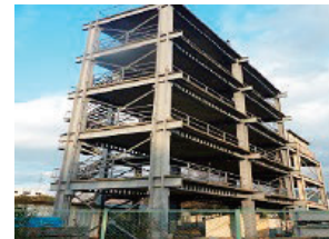
A-3鋼構造実大試験架構
