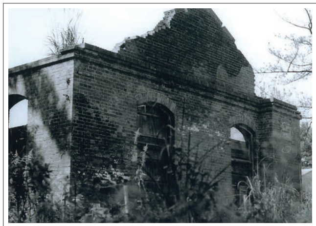
旧日本陸軍火薬庫跡の煉瓦作りの建物。碧水会のバドミントンの試合会場としても使用された。(1973年頃撮影)
