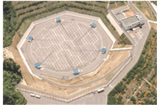
図1: MUレーダー。中央の円形の部分が475本の八木アンテナから構成されるフェーズド・アレイ・アンテナ(直径103m)。
