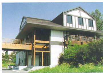
写真1 木質材料実験棟全景
