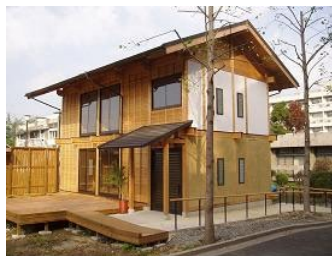
写真2 実験住宅「律周舎」
