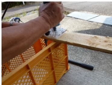
写真7：V字溝加工
