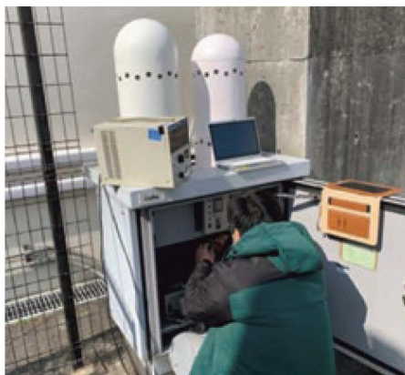
屋外モニタリングポスト修理
