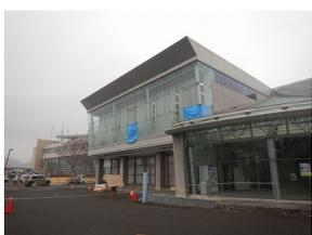
写真8 ガラスの被害\*
