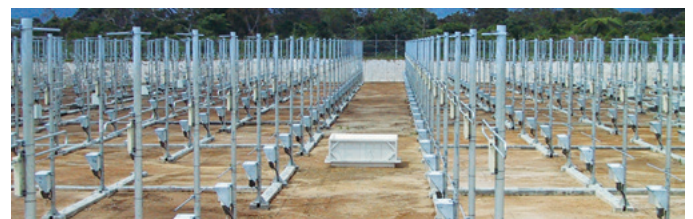
赤道大気レーダーアンテナ (直径110mの円形敷地に560本の八木アンテナを備える)
