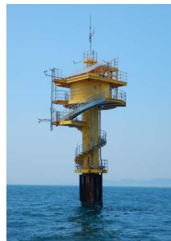
田辺中島高潮観測塔
