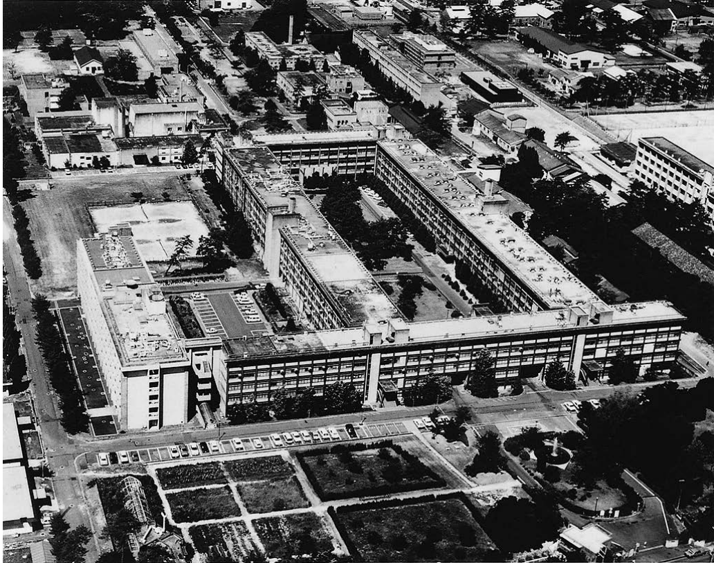
宇治構内総合研究棟（1970年竣工）
