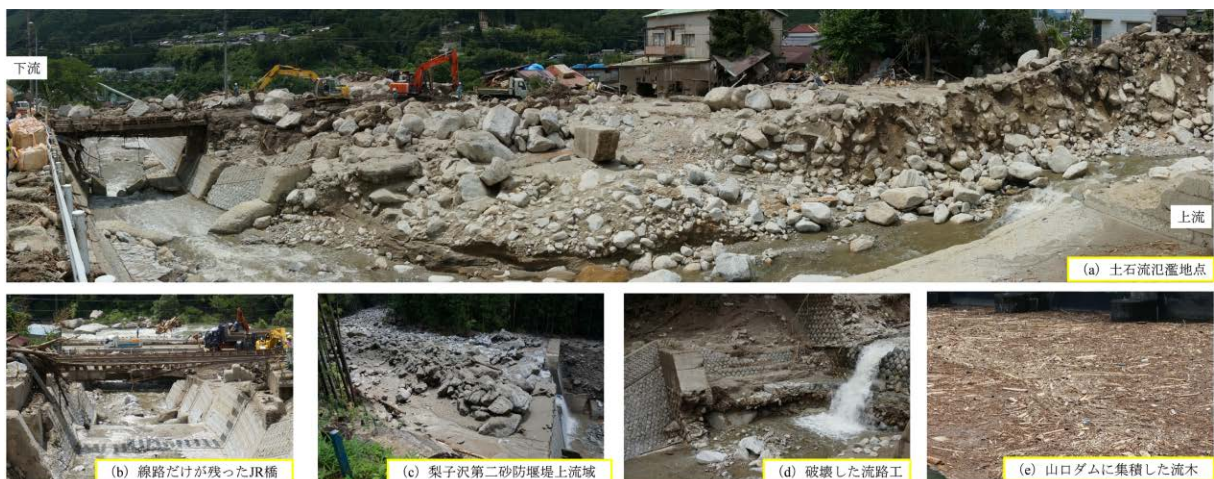
被災後の梨子沢と山口ダムの様子
