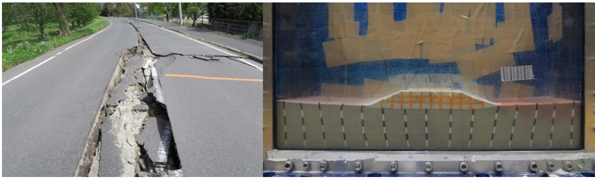
図1 盛土に発生する開口クラックの実例と遠心場模型実験での再現例
