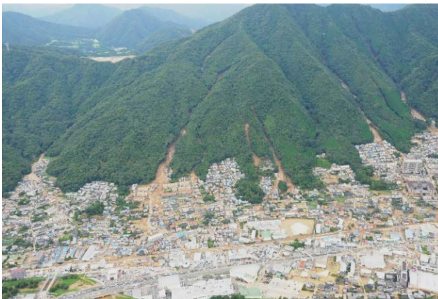
土石流による沖積錐上住宅地の被災状況
