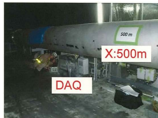
重力波望遠鏡 KAGRA の安定動作のために併設された長基線レーザー歪計のデータ収録装置
