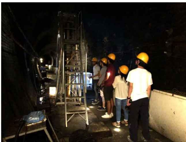
観測坑道内の地下水位観測装置
