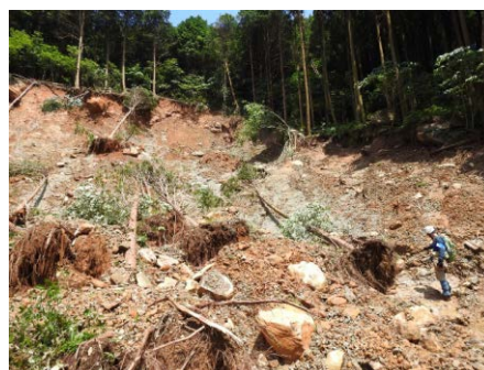
図2 令和2年熊本豪雨災害における津奈木町の斜面崩壊地の調査
