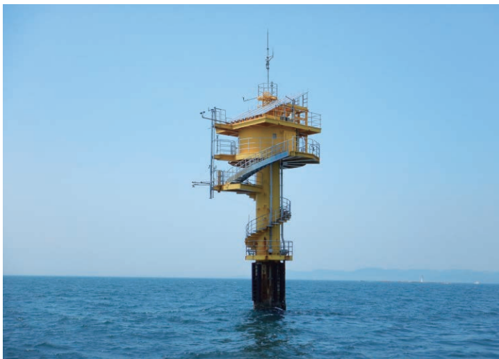
白浜海象観測所高潮観測塔
