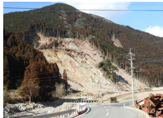
小野地区の深層崩壊
