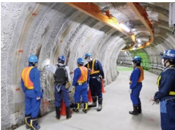
◀ 幌延町での現地検討会での地下岩盤見学の様子 Underground rock mass in Horonobe
