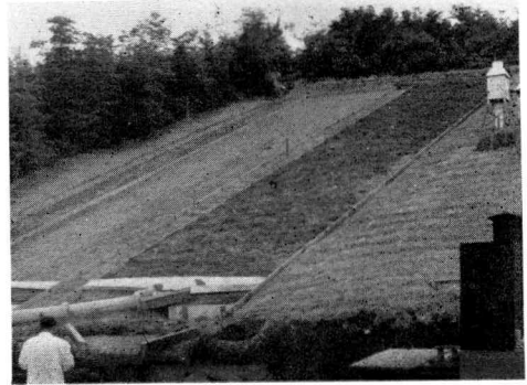
Erosion に関する試験地
