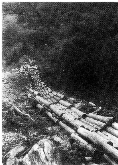
写真-24 杉丸太による修羅の構造
