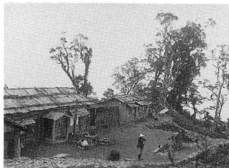
写真36 池鯉鮒駐在所付近
