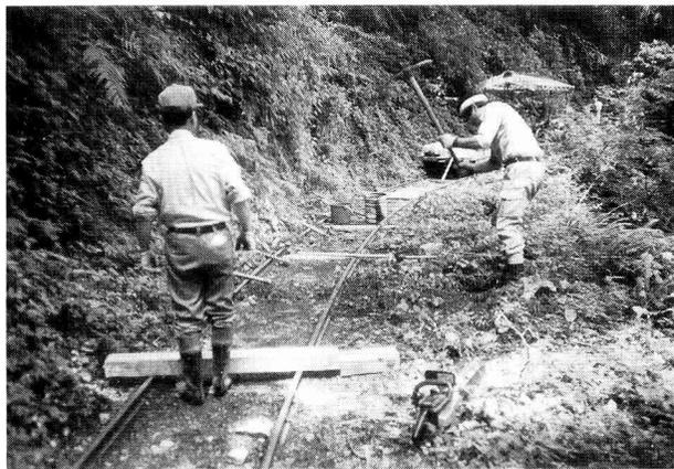
写真21 軌道補修・枕木交換(平成5年)
