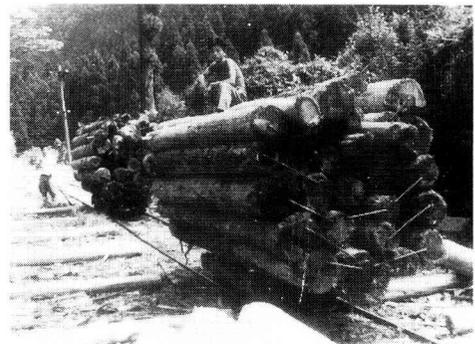
写真8 ゲタトロによる運搬(昭和31~33年)
