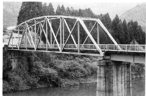
写真-4 萱野橋 (5カ所で営巣していた)
