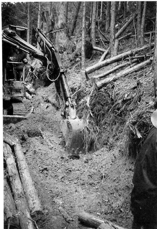
写真-1 バックホーによる法面拡幅作業
