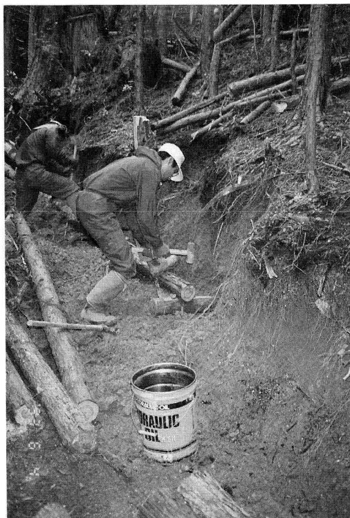
写真-2 丸太積作業
