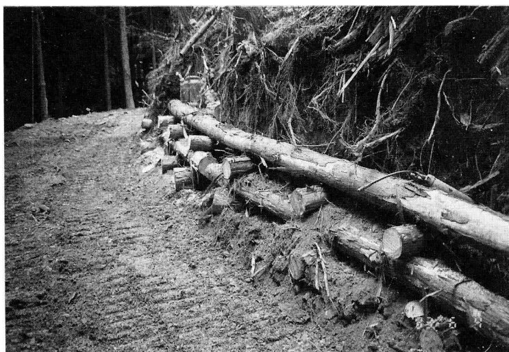
写真-3 完成した法面
