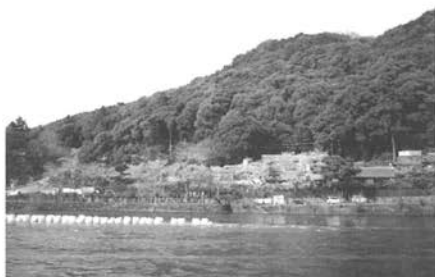
b：宇治川塔の島付近に並べ置かれた砂袋（もっと上流にあったものは一部を残して流失した）
