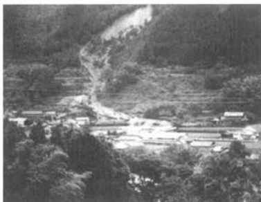
a：崩壊の初期
