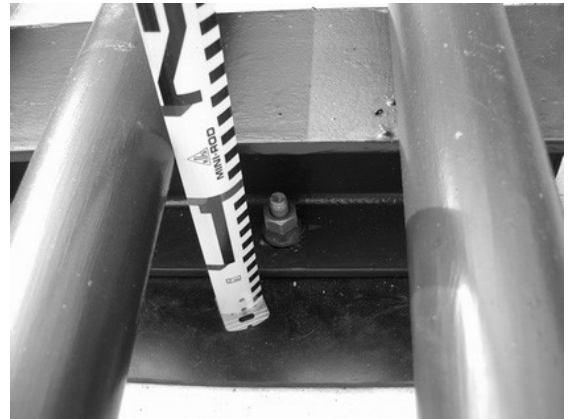
写真-20 コンクリート台とのアンカー固定
