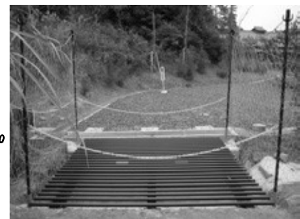
写真-1 設置状況
