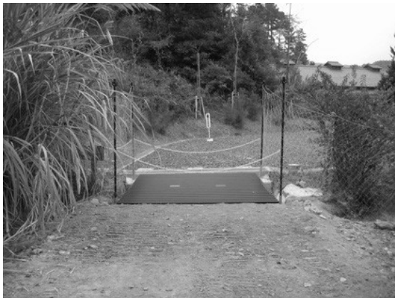
写真-21 完成：上賀茂試験地側
