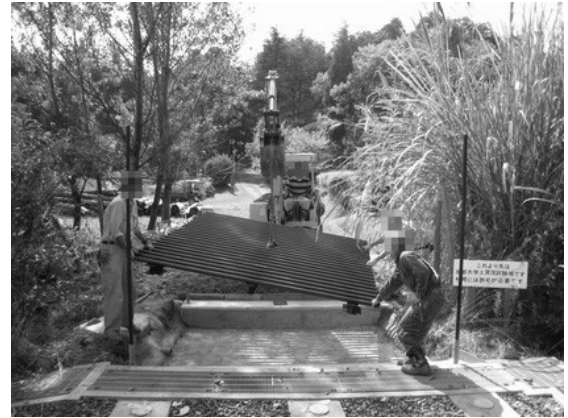
写真-16 鋼製床版パイプ取付け
