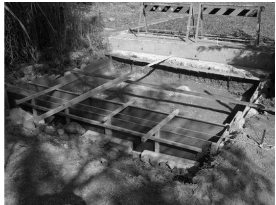
写真-10 型枠組立
