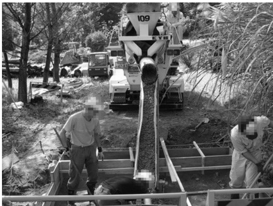
写真-11 コンクリート(18-8-40)打設
