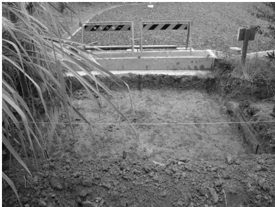
写真-9 床堀完了
