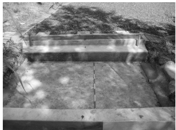
写真-14 脱枠状況
