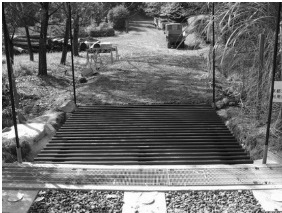
写真-17 鋼製床版パイプ取付完了
