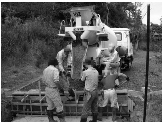
写真-13 コンクリート(18-8-20)打設
