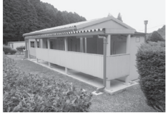
作業所トイレ更新及び連絡通路
