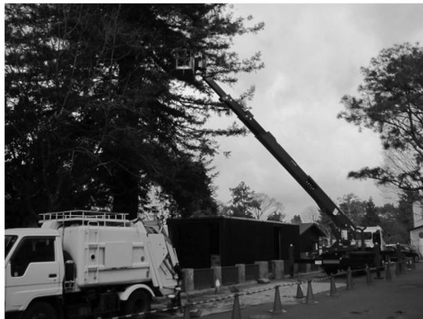
危険木枝下し作業
