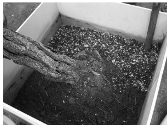
写真6 改良土の入れ込みと突き固め
