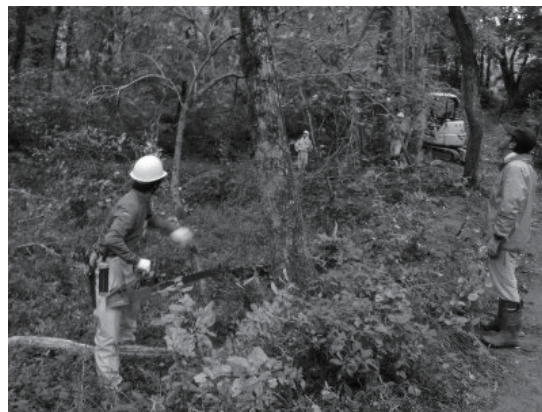
侵入した樹木の伐採作業
