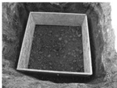
写真2.基盤用の型枠を設置
