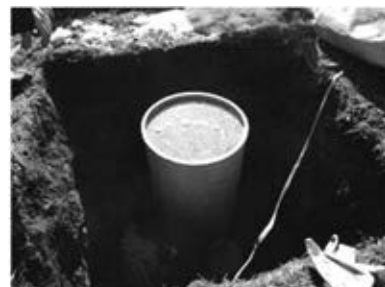
写真3.セメントを流し込む
